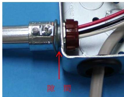
欠陥：ボックスと管との接続がゆるい
