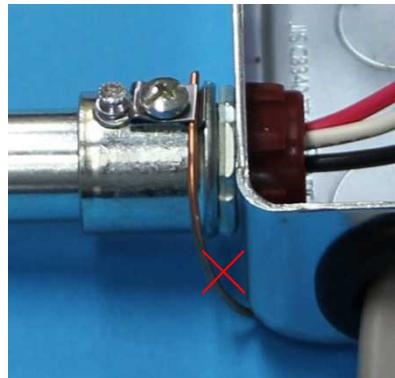
欠陥：ロックナットがボックスの外
